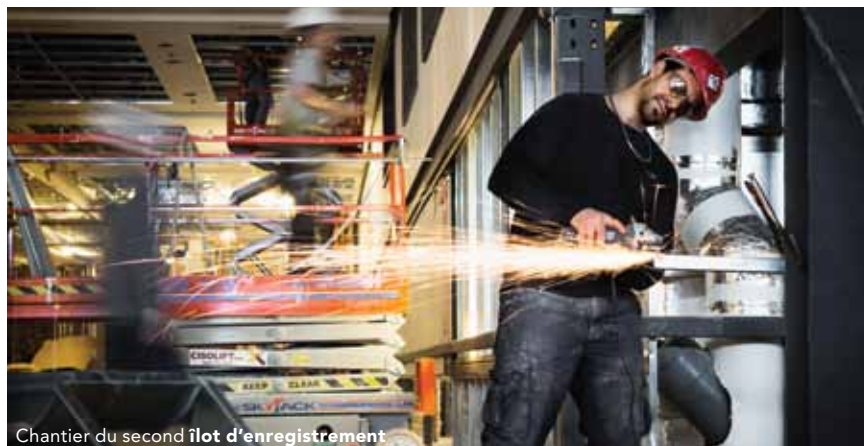
Chantier du second îlot d'enregistrement
